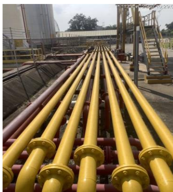
ภาพที่ 2-11 อุปกรณ์ดับเพลิงภายในคลัง
