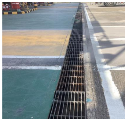
ภาพที่ 2-2 รางระบายน้ำคอนกรีตภายในคลัง
